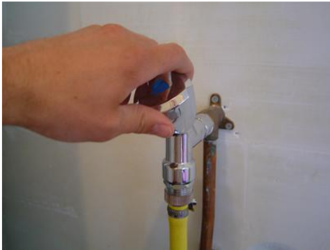
STAP 7; Sluit de vulkraan (rechtsom kwartslag).
