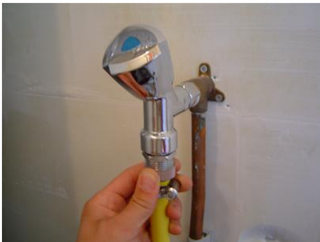
STAP 8; Sluit de wasmachinekraan (rechtsom draaien).
